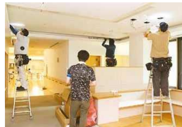
LED証明交換作業の様子
